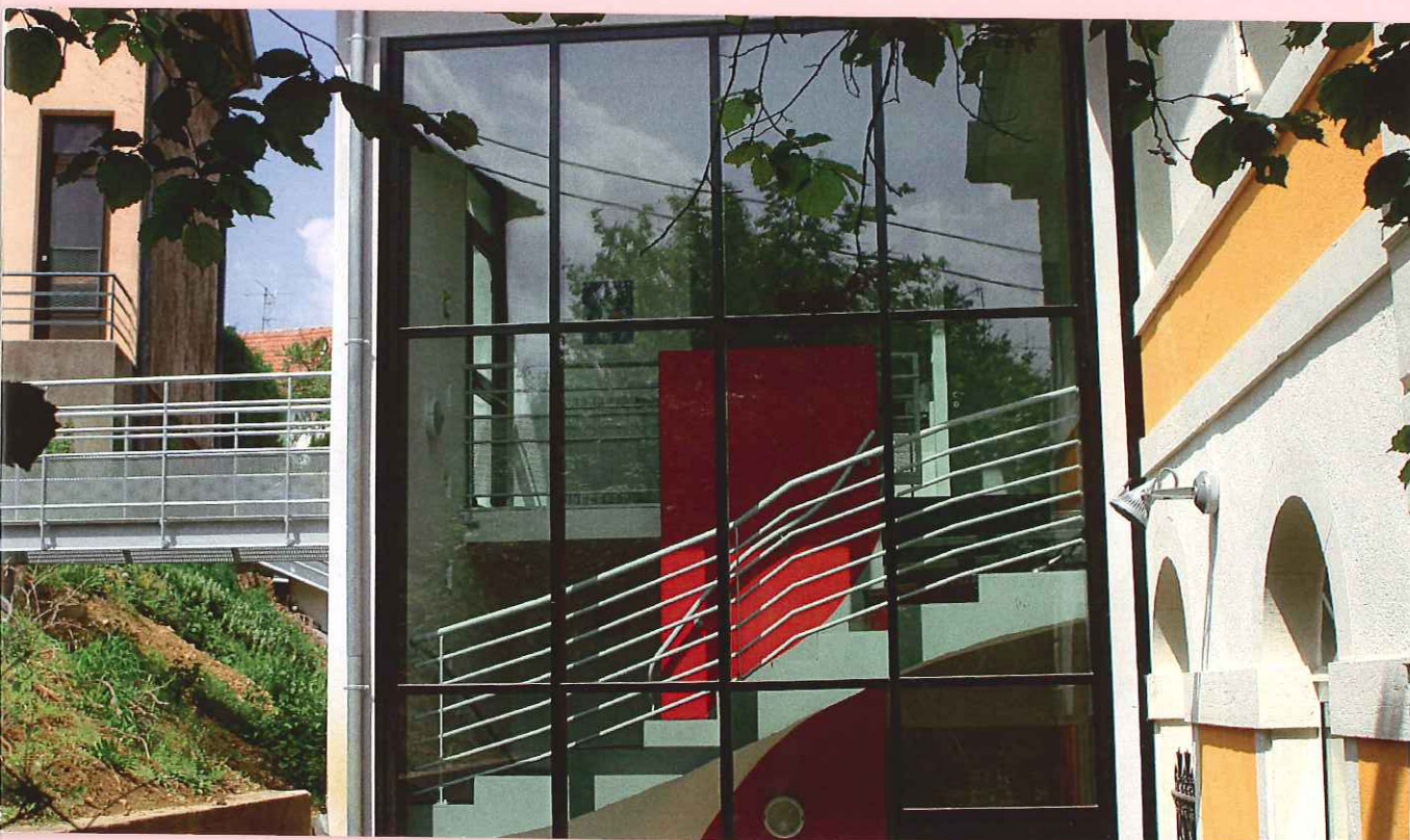
Accueil Périscolaire Intercommunal Jean de La Fontaine
